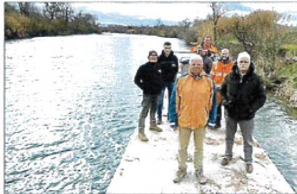
Les élus locaux visitent le chantier sur la barge.
