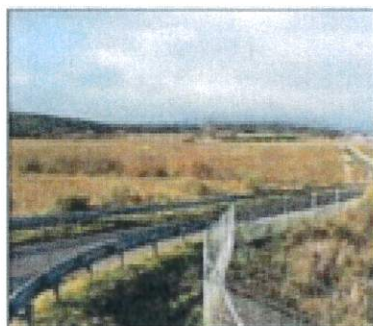
Un barrage écrêteur, retenant les eaux sur une surface de 64 hectares, verra le jour dès 2025.
