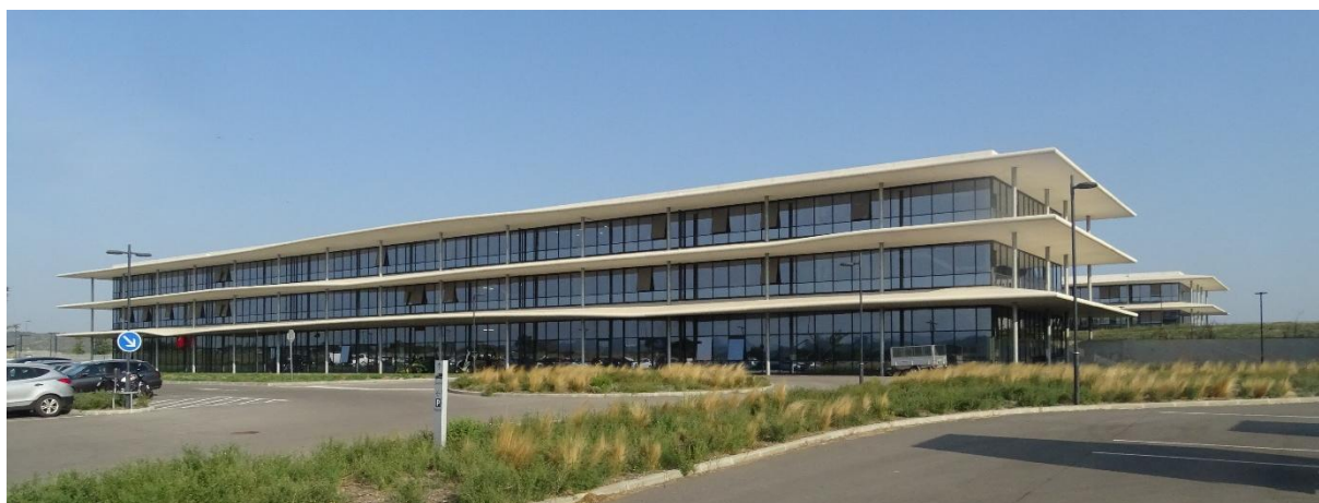
Photo 7 : Le lycée Ernest Ferroul, équipé d'un réseau de chaleur – Source : EVEN Conseil
