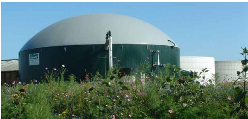
Photo 6 : Exemple d'unité de méthanisation agricole – Source : Chambre d'agriculture de l'Aude
